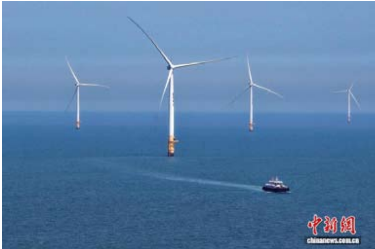
6月10日，航拍江苏南通海上风电场的巨型风机。（中新社）
